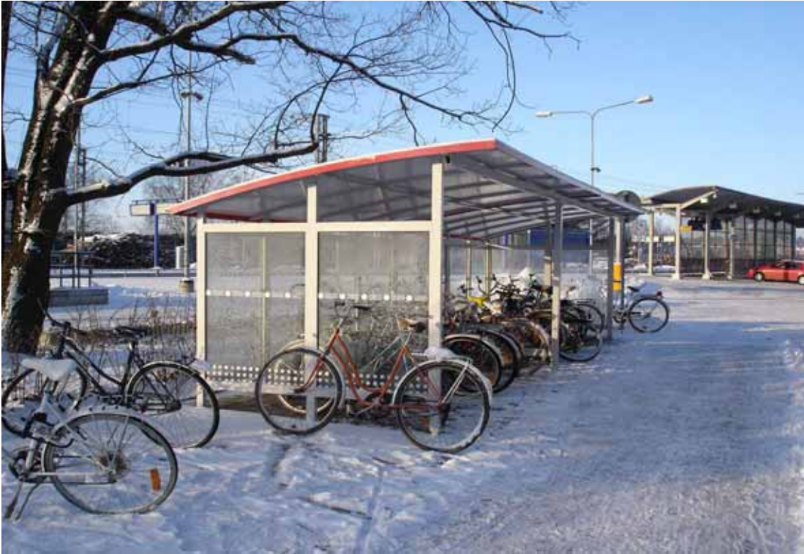
Kuva 7. Salon rautatieaseman pyöräkatos valmistui tammikuussa 2004.
